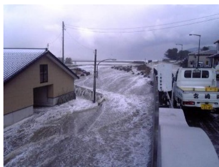
23 図 7-32 寄り回り波による被害 24 (平成 20 年 2 月、宮崎漁港海岸)
