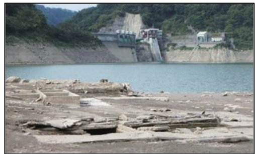
水位が低下して湖底が一部見えている刀利ダム (出典: 富山県)
