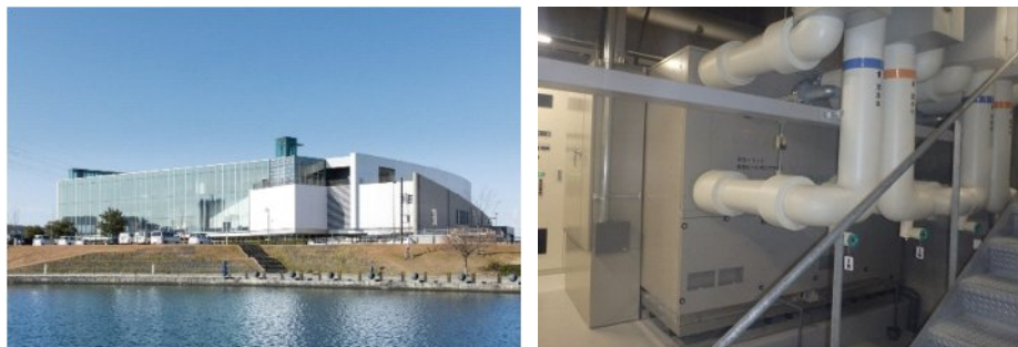
22 図 6-5 富山県美術館に導入された地中熱（地下水熱）ヒートポンプによる冷暖房システム
