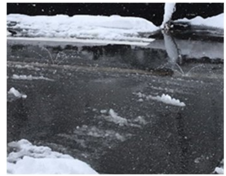
図 7-23 地下水を利用した消雪設備
