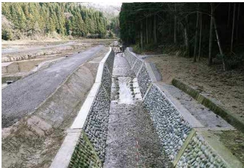
夏野土木工業(株)施工の「片貝川水系尾山大谷川砂防関係施設整備(砂防)護岸工工事」
