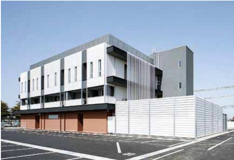
射水建設興業・和田鉄工建設富山県高岡児童相談所移転改築工事 共同企業体施工の「富山県高岡児童相談所移転改築工事」
