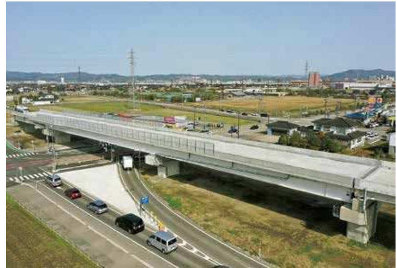
川田工業(株)施工の「主要地方道高岡環状線道路改築橋梁上部工（4工区）工事」
