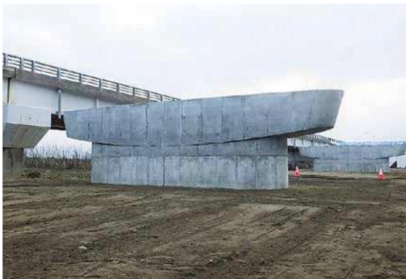
五本建設(株)施工の「主要地方道富山魚津線道路橋りょう改築 今川橋下部工（P2橋脚）工事」
