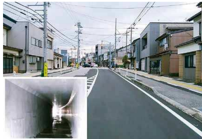
朝野工業(株)施工の「鴨川河川改修放水路工工事」
