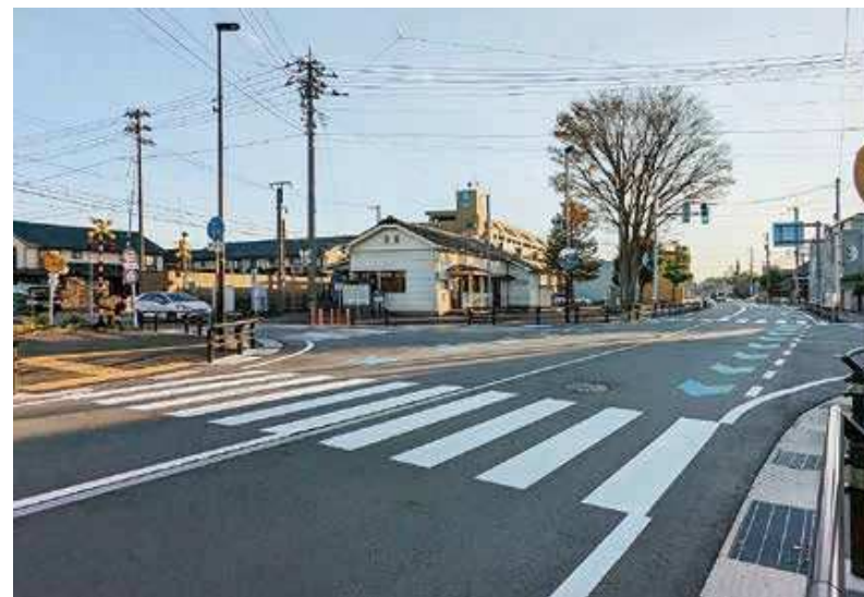
伊野建設(株)施工の「主要地方道富山魚津線県単独道路改良 その2工事」
