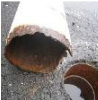
支柱の根腐れによる倒壊
