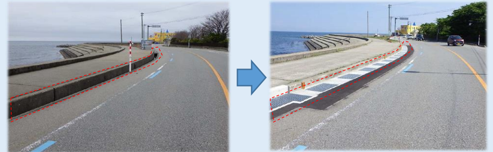
蓋のない側溝の改修による事故防止対策
