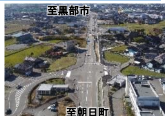
国道8号入善黒部バイパス
