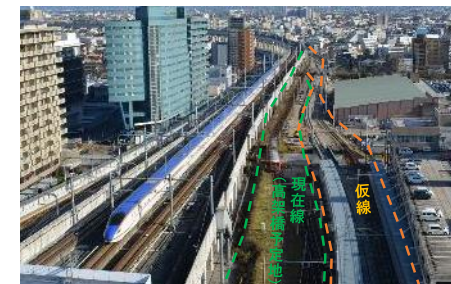
富山駅付近連続立体交差事業 (富山地方鉄道本線)
