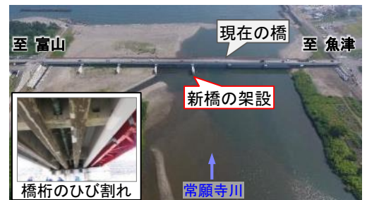
県道富山魚津線 今川橋の架替
