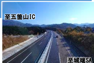
4車線化の一部供用区間
