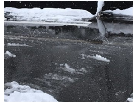
図 7-23 地下水を利用した消雪設備
