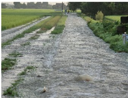
図 7-20 農業用水路からの溢水被害 （平成 26 年 7 月、高岡市）
