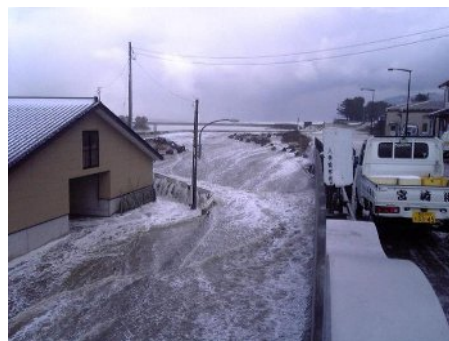
図 7-32 寄り回り波による被害 (平成 20 年 2 月、宮崎漁港海岸)
