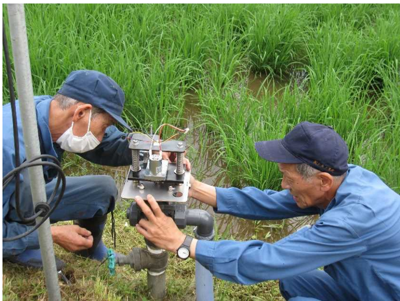
自動給水栓による管理
