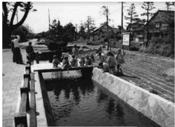
射水市 堀岡雨水幹線
