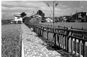
溶融スラグを有効利用したインターロッキングブロック(埋戻材・敷均材)
