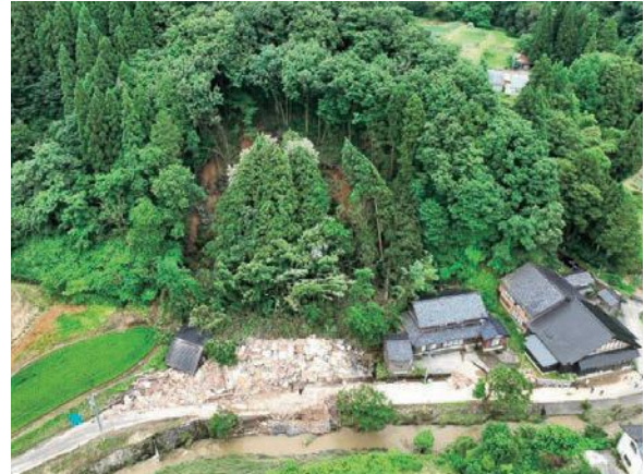
砂子谷 [令和5年7月 南砺市]
