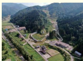
南砺市利賀村の土砂流出対策
