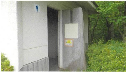
②公衆トイレの停電
