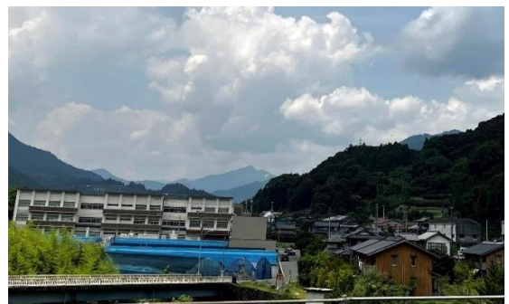
高等専門学校建設予定地
