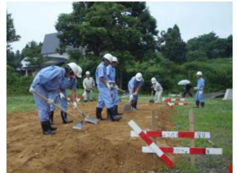
(仮設道路製作実習の様子)
