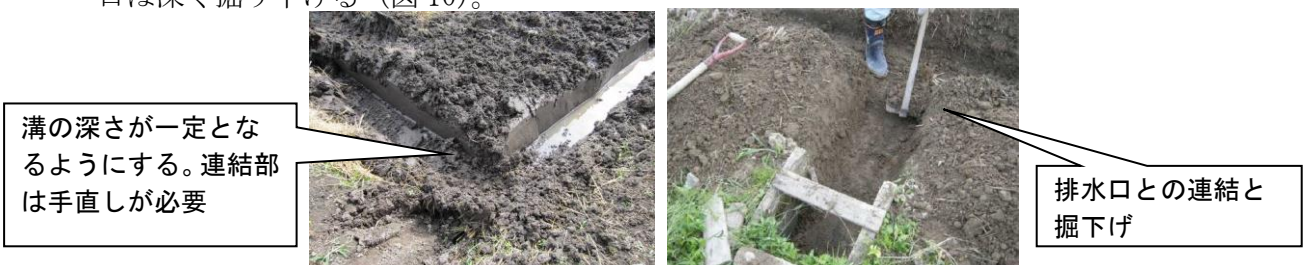
図10 額縁排水溝・排水口の連結手直し
