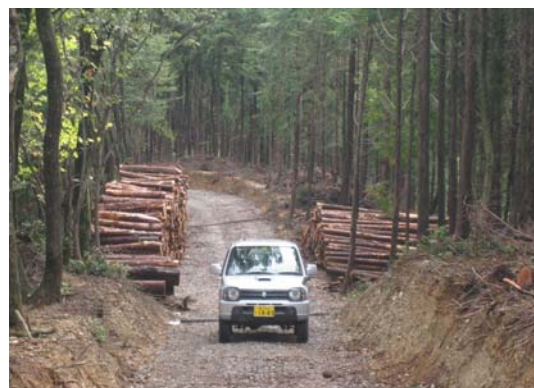
施業集約化を促進する作業道
