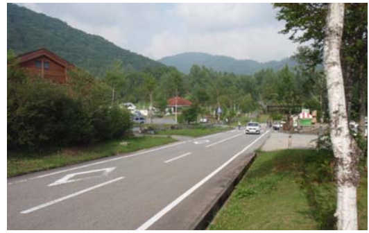
山村環境を改善する林道
