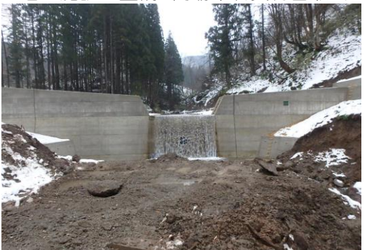
治山施設の整備 (南砺市利賀村百瀬川)
