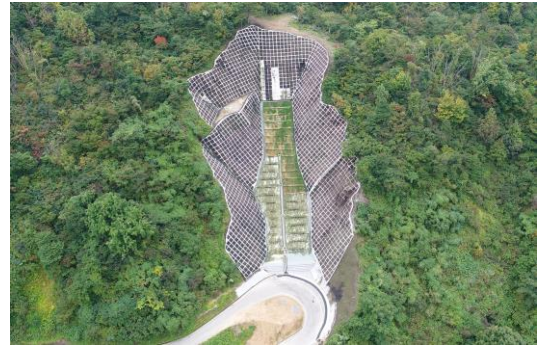
水源地域の荒廃地の復旧 (上市町伊折外)
