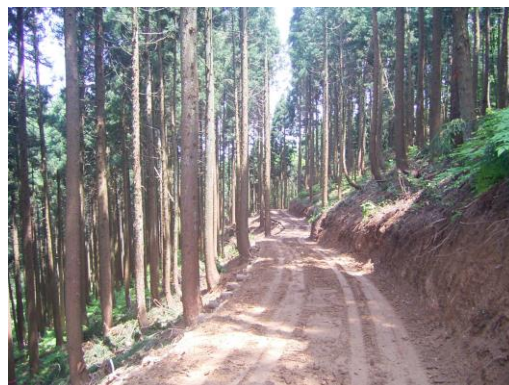
森林作業道の開設
