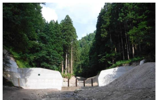
治山施設の整備 (南砺市利賀村坂上)
