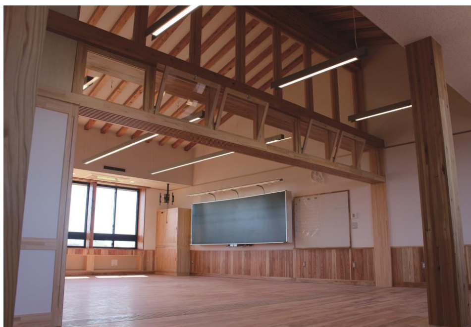
県産材を利用した全国初の木造3階建て校舎〔魚津市星の杜小学校〕
