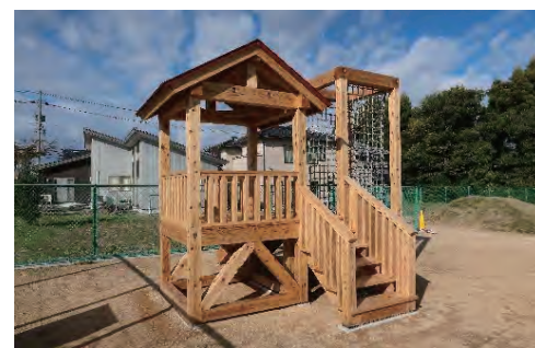
屋外遊具の設置 （富山市青い鳥幼稚園）
