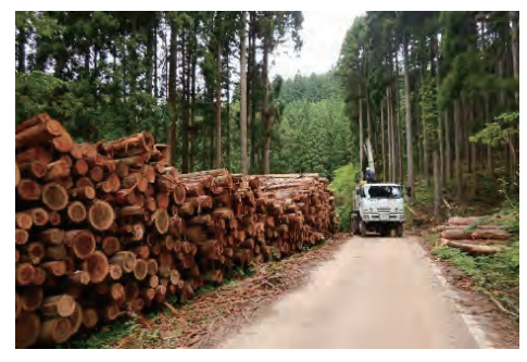
木材の運搬に利用される林道 (福平池尻線 黒部市)
