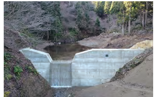
崩壊地の荒廃地復旧 (南砺市太谷川)
