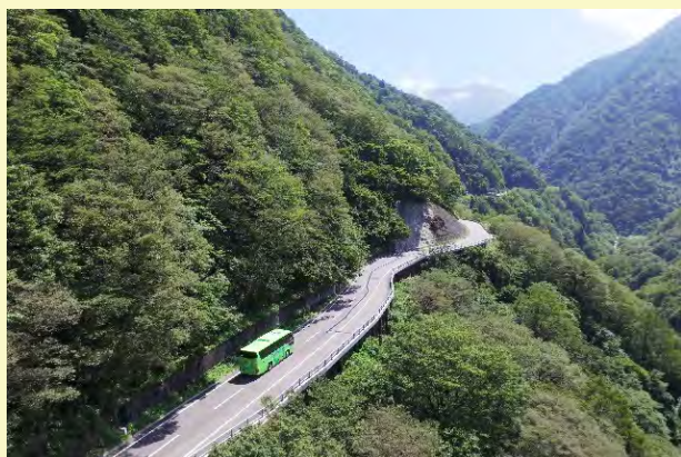
林道有峰線「小見区間」
