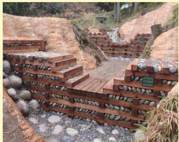
令和4年度魚津市東城での試験施工の様子
