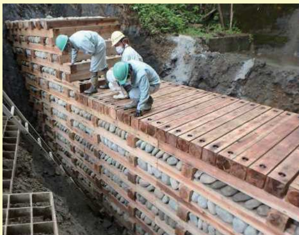
令和3年度氷見市小竹での試験施工の様子
