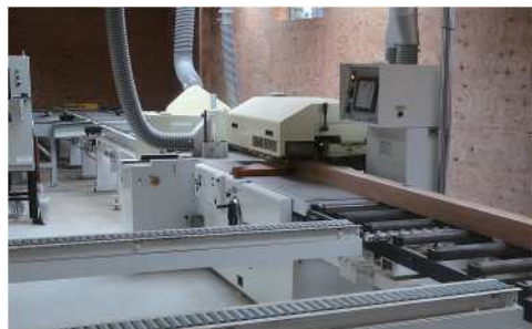
木材加工施設に導入したプレーナー（鉋仕上機械）（入善町入膳）
