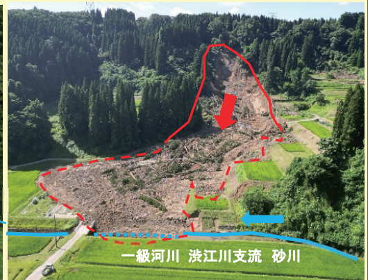
令和5年7月 小矢部市道坪野地内
