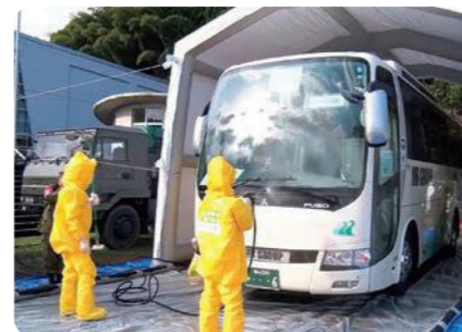
放水による 車両の簡易除染
