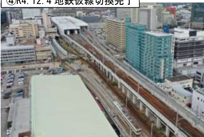
④R4. 12. 4 地鉄仮線切換完了
