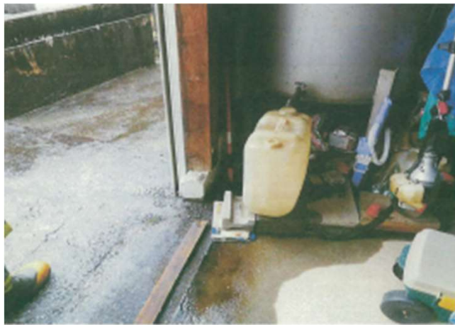
小分け中の灯油漏えい
