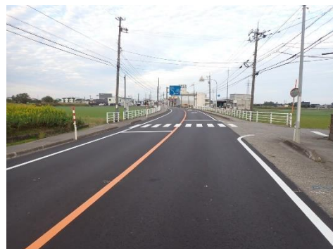
道路の舗装補修(補修後)
