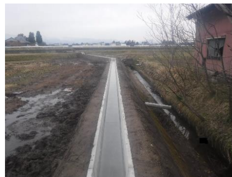
農業用水路の改修
