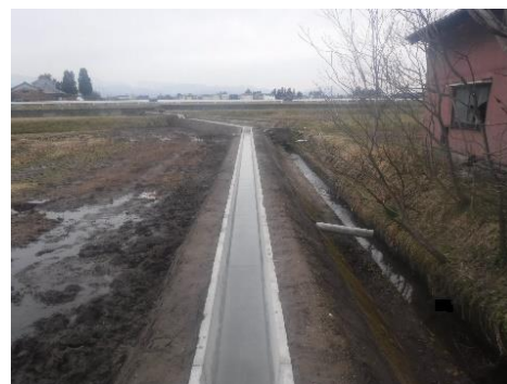
農業用水路の改修
