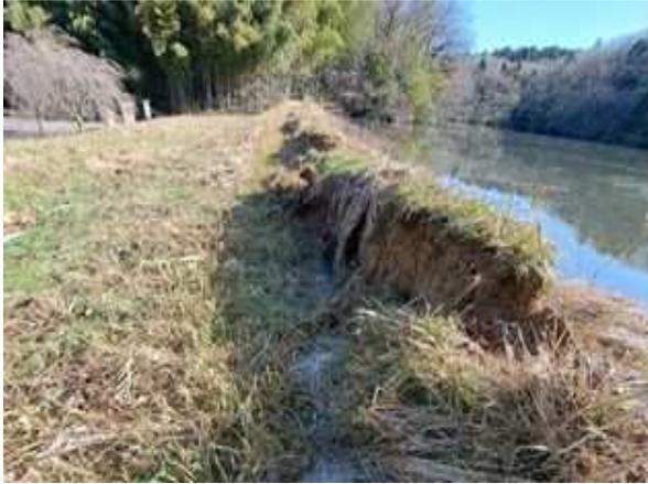
農業用ため池の堤体沈下
