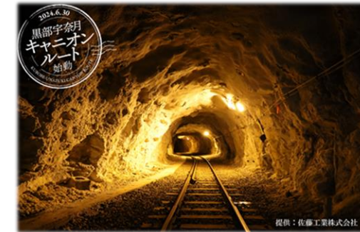
キャニオンルート内「高熱隧道」
