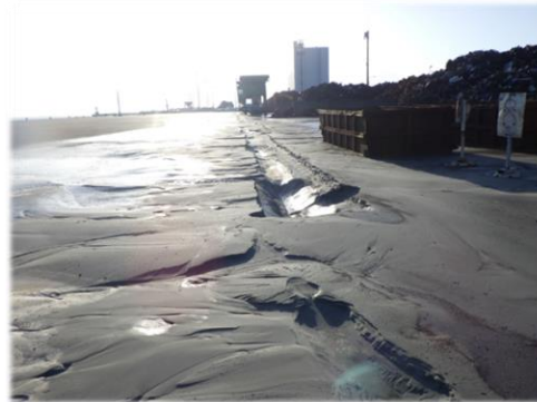
伏木富山港(伏木地区)
