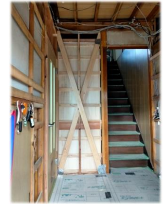
耐震改修工事
