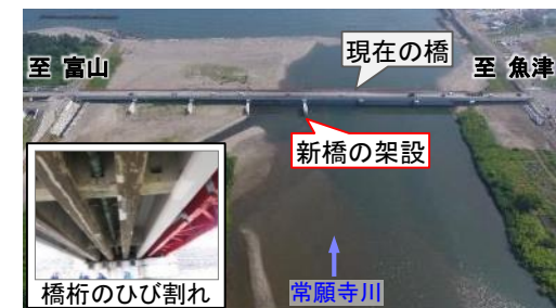
県道富山魚津線 今川橋の架替
