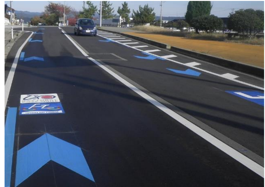
矢羽根型路面標示の整備
