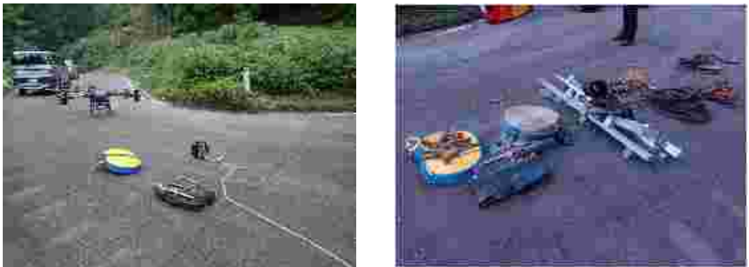
ドローンによるリードロープの運搬状況
