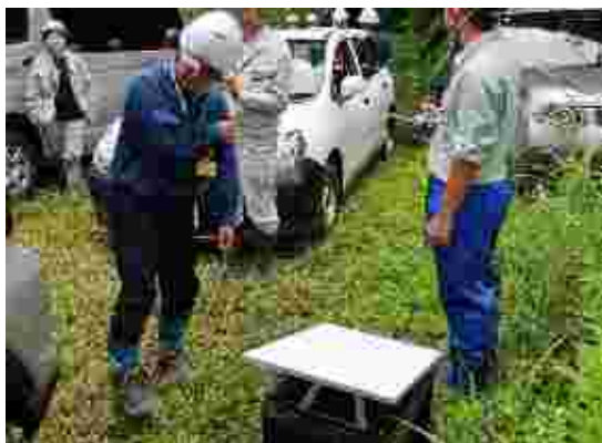
低軌道衛星アンテナの設置
