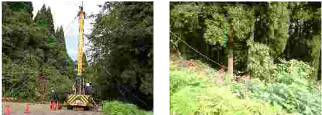
控え索の設置状況
