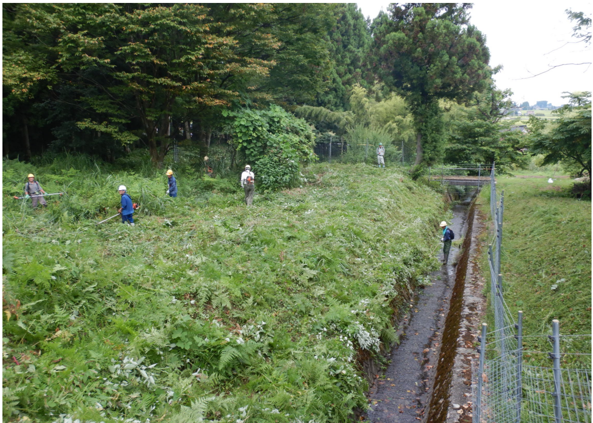
暑い中の作業と、皆さんの熱意が伝わる現場でした。
