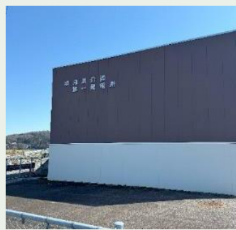
上流部の既設水力発電所
