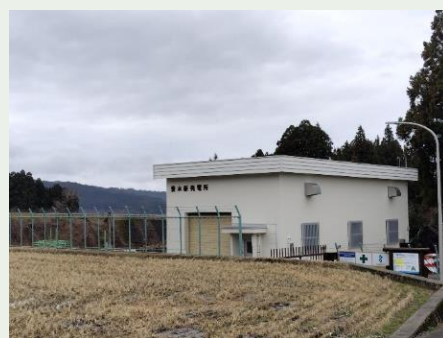
上流の既設水力発電所
