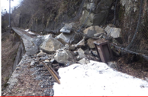
軌道を損傷させて堆積した巨礫
