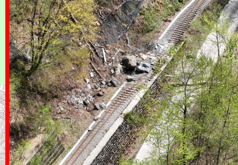
斜面崩壊・落石による軌道施設の損傷
