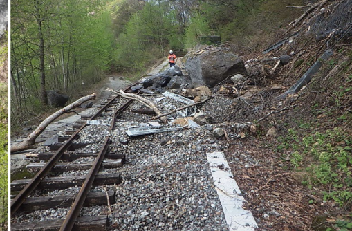
軌道を損傷させて堆積した巨礫
