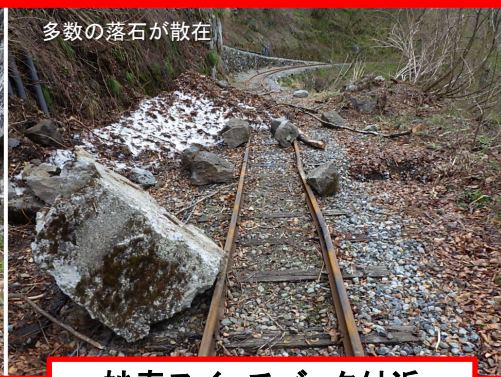
斜面崩壊・落石による軌道施設の損傷
