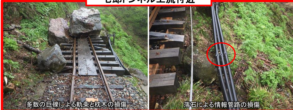
七郎トンネル上流付近
