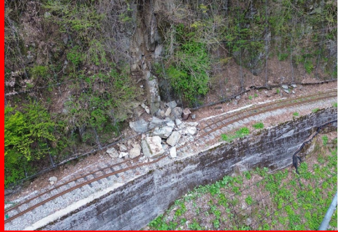
岩盤崩落による軌道施設の損傷
