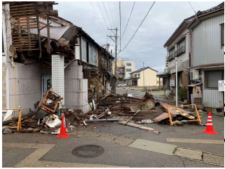
倒壊した家屋（氷見市）
