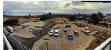
液状化被害（高岡市）
