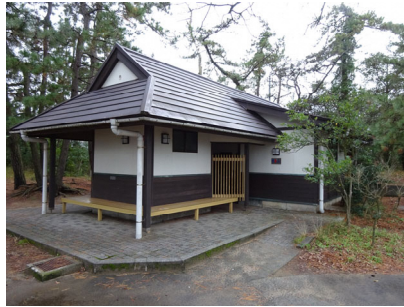
管理休憩所・公衆便所
