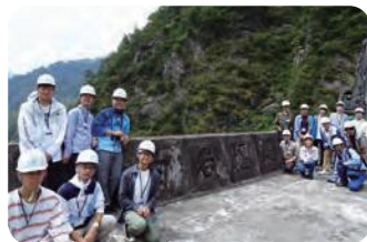
白岩堰堤 (重要文化財)
