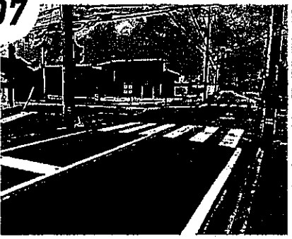
一般県道黒川滑川線 道路改良工事(下島地内)
