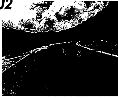
宇奈月大沢野線(養輪工区) 県単独道路改良舗装工
