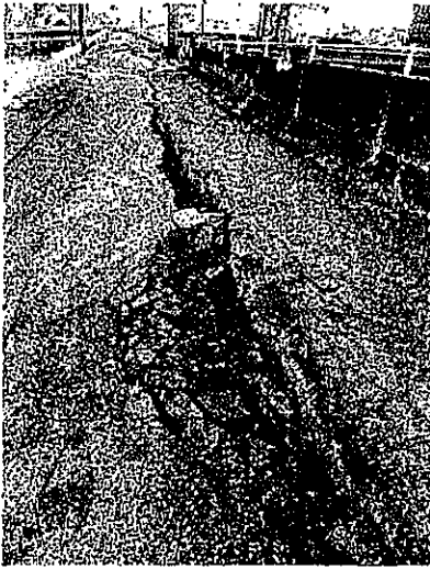
道路断裂(高岡市永楽町)
