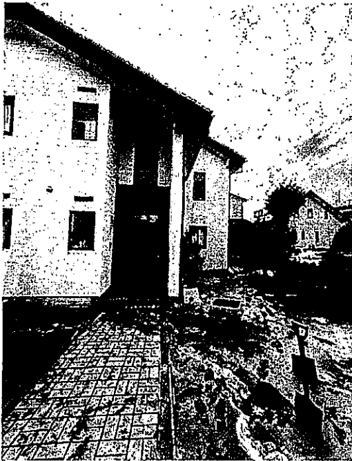
液状化により傾く家屋（富山市蓮町）
