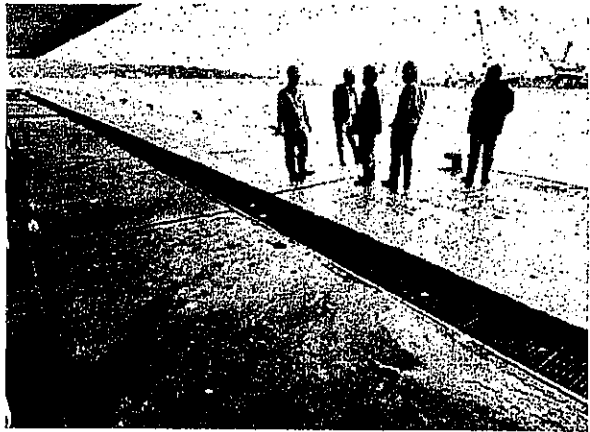
氷見漁港の陥没
