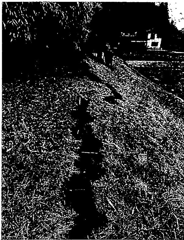
ため池の亀裂
