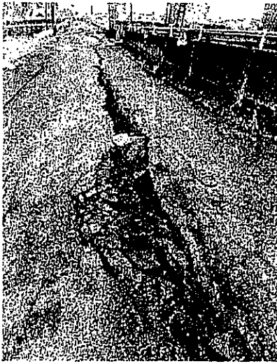
道路断裂(高岡市永楽町)
