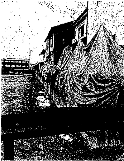
液状化現象により家屋傾斜 (高岡市横田町②)
