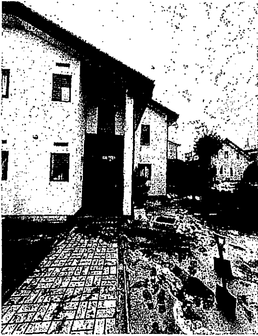
液状化により傾く家屋（富山市蓮町）
