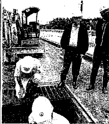
上田子「排泥弁」操作視察
