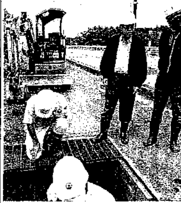
上田子「排泥弁」操作視察
