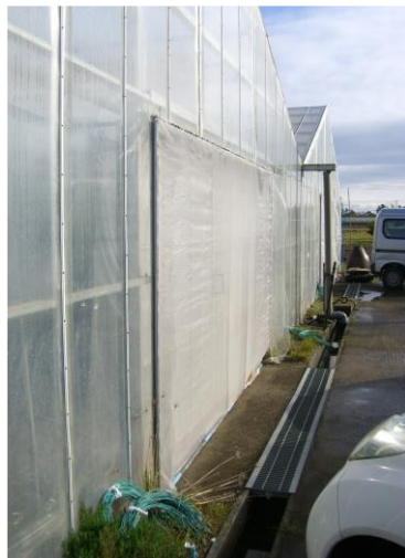
図5 ネットの展帳の例② (入口に2重ネットを設置)
