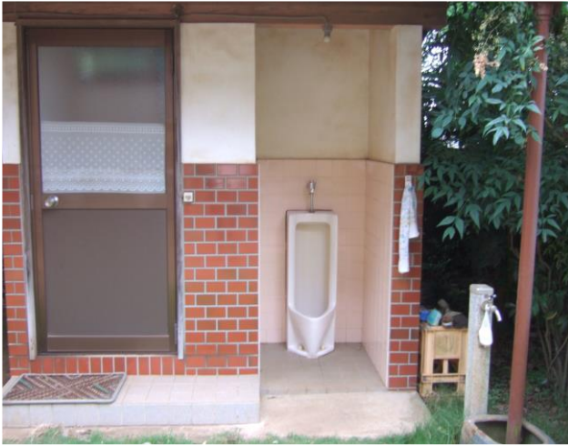
図1 トイレ・手洗い設備の設置
