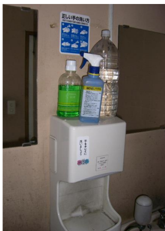
図3 洗浄・消毒器具の設置
