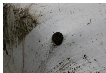
写真2 ラップの破損
