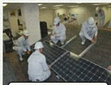
太陽光パネル整備
