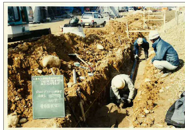
圧送管敷設時の様子
