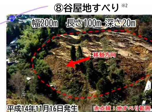
・秋雨前線による長雨を誘因とする地すべり
