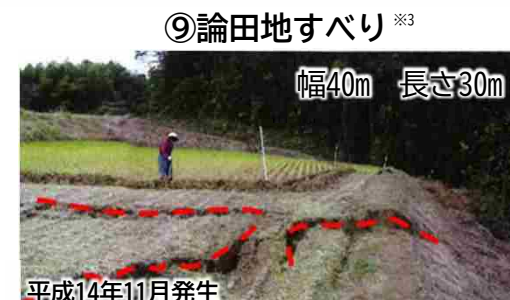
・秋雨前線による長雨を誘因とする地すべり
