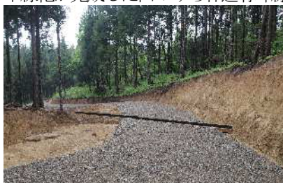
スギ林内に完成した林業専用道
