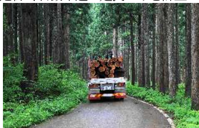
木材搬出に用いられる林道
