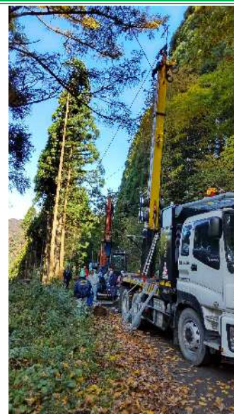
タワーヤーダによる集材
