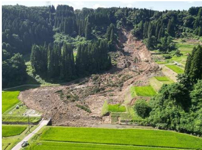
豪雨による地すべり被害 (R5年7月小矢部市道坪野)
