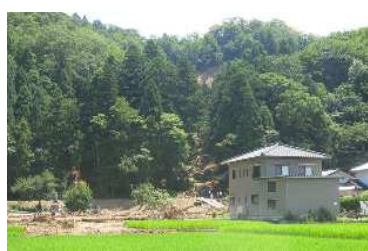
被災直後 (平成 26 年 7 月撮影)
