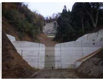
工事完成直後 (平成 27 年 12 月撮影)
