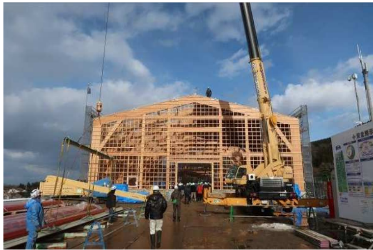
CLTを活用し建設中の木造建築物を題材とした現地研修会
