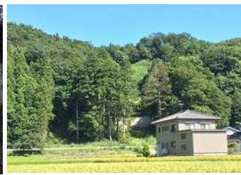
工事完成 3 年後 (平成 30 年 9 月撮影)
