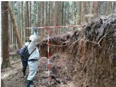
地震で発生した地すべり
