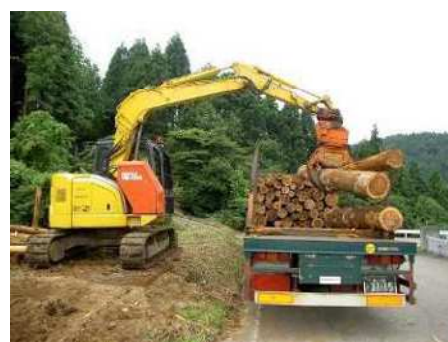
主伐に対応した路網整備
