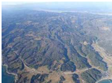
上空からの山地災害の調査
