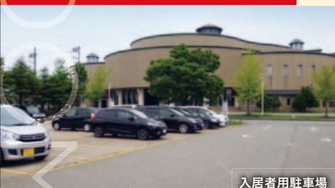
入居者用駐車場
